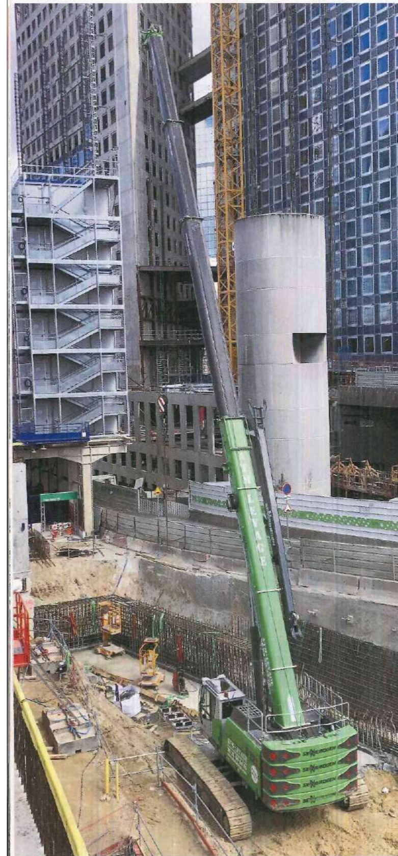
La Sennebogen 673 a été exploitée sur le chantier de la tour Hekla.
