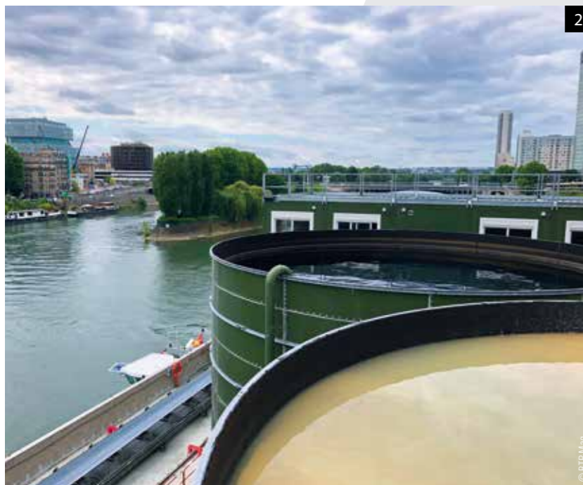
2/ Des cuves d'une capacité de 500 m 3 .
